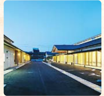
13 야쓰나미 홀, 광풍관(光風館) 각종 영수나 휴게, 숙박 등 다목적 홀로서 이용 가능함
